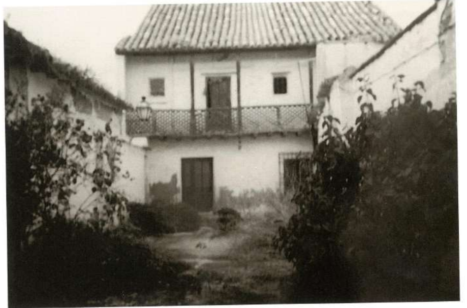
Casa del Pueblo en la calle Progreso y antigua sede de U.G.T. en el año 1934 (Severiano Rodríguez del Cerro)
