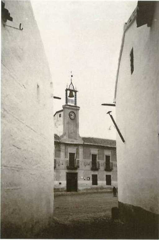
Fachada del Ayuntamiento vista desde el callejón de Vaquero Año 1936 (Pedro Lázaro-Carrasco Baquerizo)
