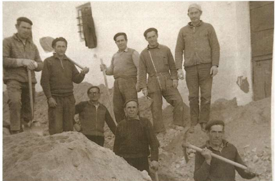
Obras de la primera acometida de agua potable en Bargas Hacia 1958 (Antonio del Salado Hernández)
