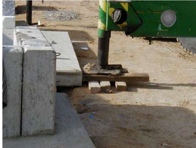
Buen apoyo de la grúa en el suelo. Uso de tabloncillos de madera
